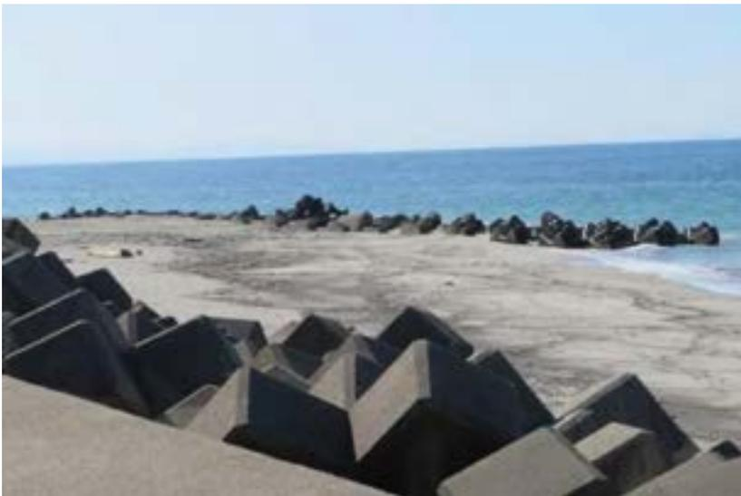
ここでも、それほど古くないテトラポットが二重に敷設されていて、テトラポットとテトラポットの間は、写真のような砂浜が生まれていることから、テトラポットの効果が見取れる。
