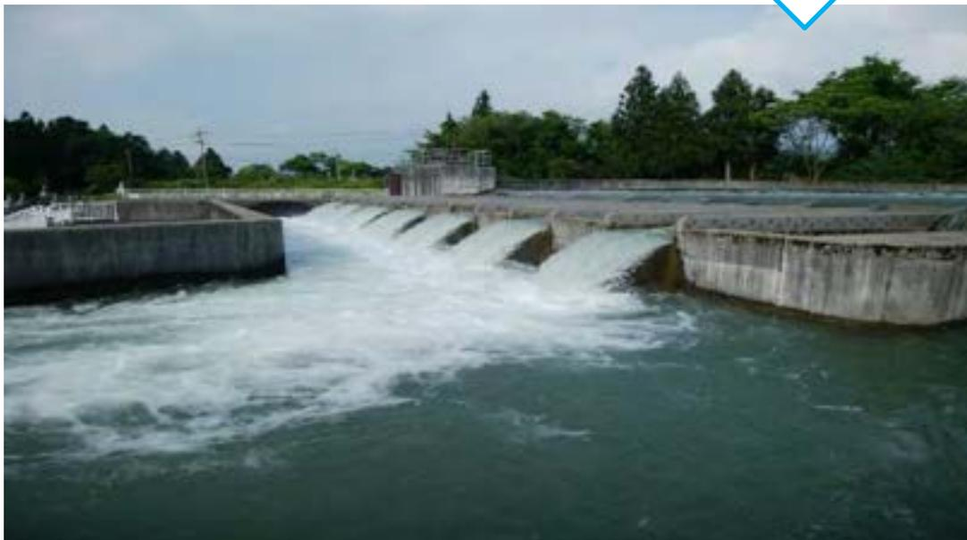
写真に写っている滝のような水は「常西」へ、その滝の間の写っていない所に落ちた水は「常東」へ流れる構造になっている。
