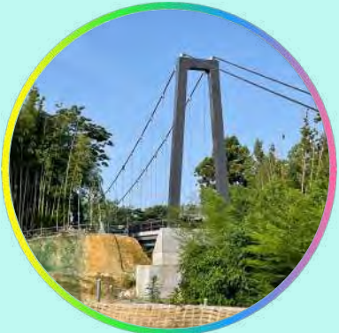
整備工事中の連絡橋 完成を楽しみに待とう！ (令和5年7月撮影)
