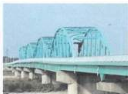
川幅が長〜い下黒部橋
